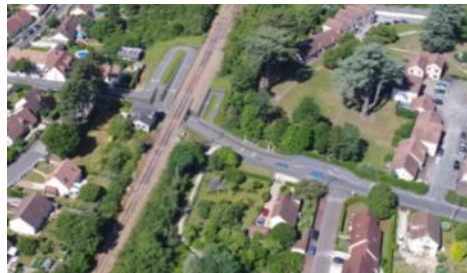
PN 97 - Saint-Jean de Braye (pont-rail à gabarit réduit)
