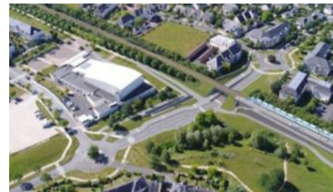
Avenue Blanche - Chécy (pont-rail)
