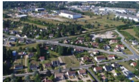
PN 110 - Châteauneuf-sur-Loire (pont-rail à une seule voie)
