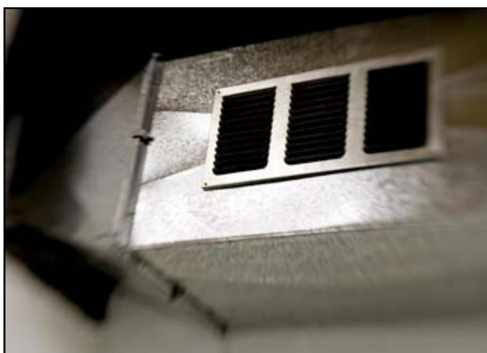
La VMC à simple flux est le système de ventilation le plus couramment utilisé dans les logements, elle peut être auto-réglable ou hygroréglable. Il peut également s'agir d'une VMC à gaz, qui assure l'évacuation des produits de combustion (chaudière, chauffe-eau à gaz) en même temps que l'air vicié, et ce, par le même réseau.
