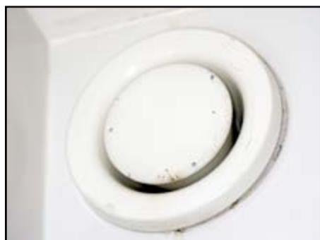
Une bouche d'extraction est un boîtier implanté dans le mur, par lequel l'air est aspiré vers l'extérieur. Elle est généralement en PVC et protégée par une grille. Pour adapter le débit d'air au besoin de votre ventilation, certaines bouches d'aération se règlent manuellement, par un clapet actionné par une ficelle.
