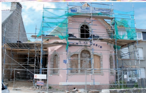
En cours de rénovation.
