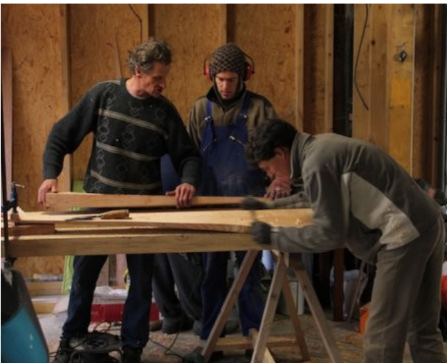
Hervé (à gauche) et deux stagiaires fabriquent les pales de l'éolienne.
