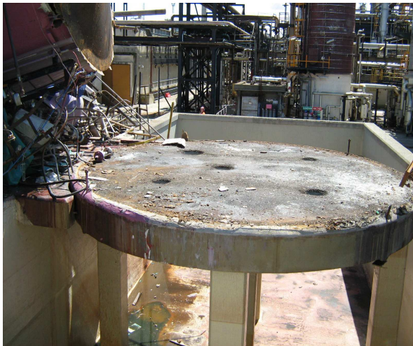
Photos DREAL : socle en béton sur lequel reposait le bac
