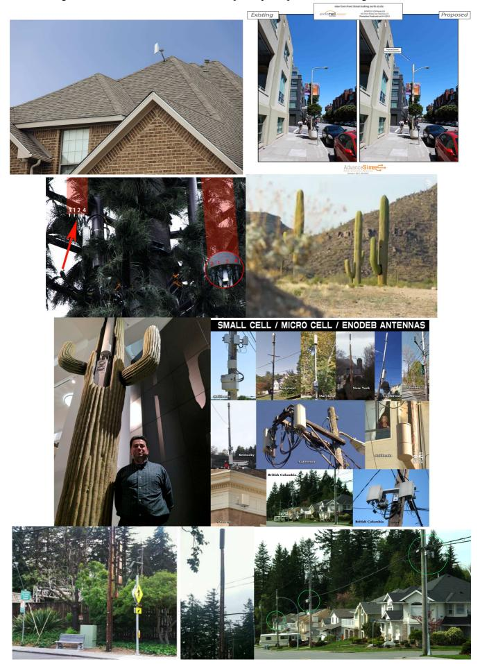
De nombreux types d'antennes sont opérationnels pour être intégrés au mobilier urbain : lampadaires, poteaux des arrêts de bus, abribus eux-mêmes... poteaux des lignes téléphoniques. Il y a aussi les faux végétaux de toutes variétés selon les régions où les antennes dissimulées devront être implantées. On remarquera que le quadrillage
