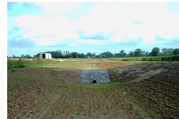
Illustration d'un seuil déversoir
