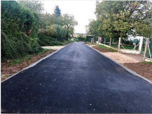
La rue des Vignes (en partie haute) et le chemin de la Calotterie ont été rénovés entièrement en enrobés bitumeux avec la pose de bordures afin de canaliser les eaux de pluies. Un ralentisseur (proche du carrefour avec la Tranchée) permet également la sécurisation de cette voirie.
