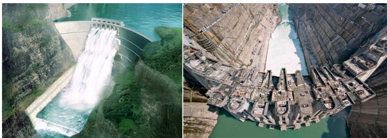
Ci-dessus : Modélisation du barrage de Baihetan, haut de 277 mètres. Vue plongeante du chantier à l'été 2019.
