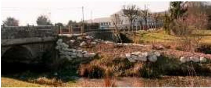
Les travaux sur la Boire.
