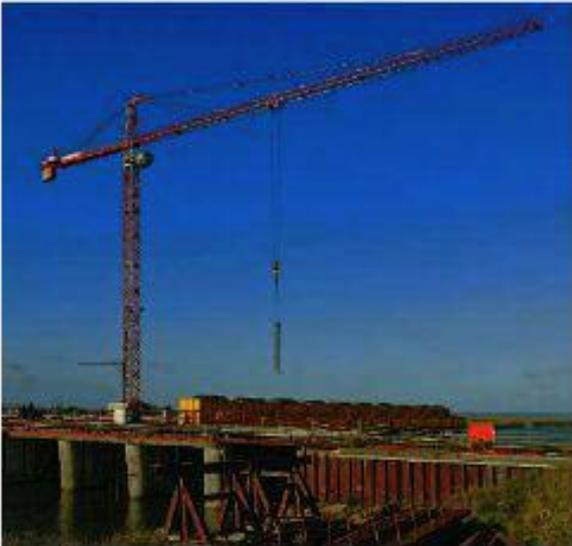
Sur cette grue, on voit une **tour**, une longue **flèche** sur laquelle un **chariot** à poulies se déplace. Une charge est suspendue à l'extrémité d'un **câble**.
