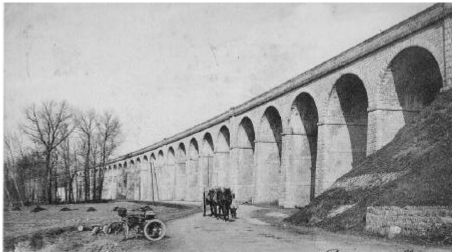
Le viaduc de Besnard à Longueville en l'an 1900
