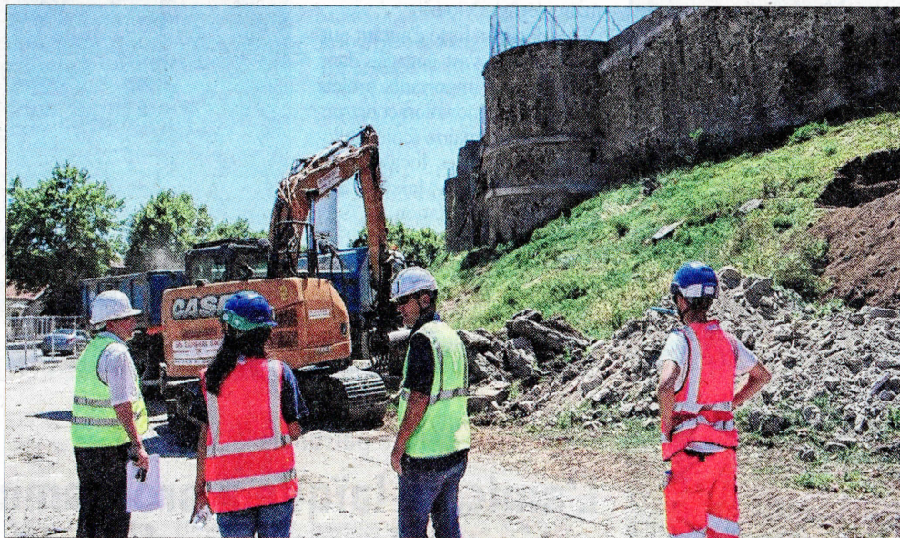
Christophe Bazile, maire de Montbrison (à gauche), lors d'une visite du chantier des Remparts en juillet. Photo Progrès/Jérôme DELABY
