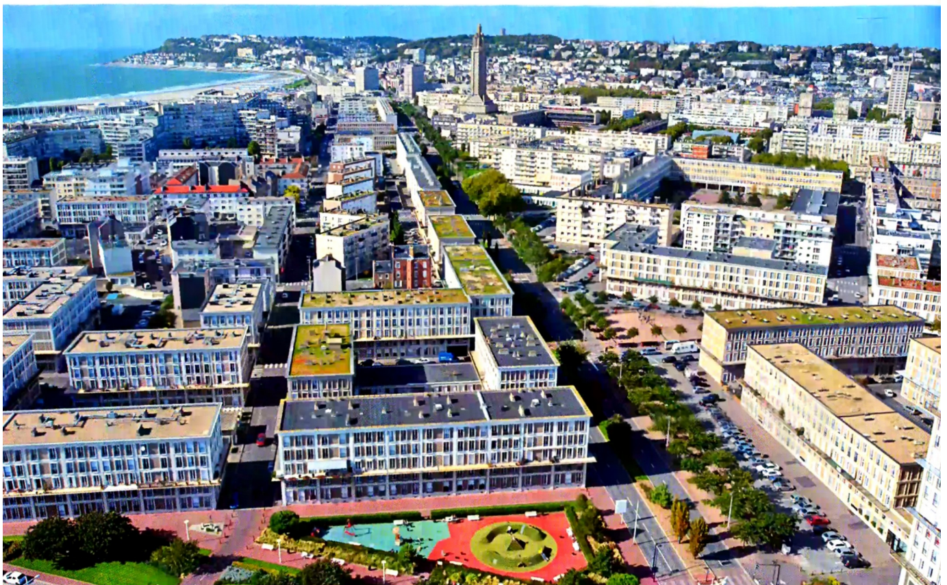
Le centre-ville du Havre reconstruit dans les années 1950 (Seine-Maritime)
