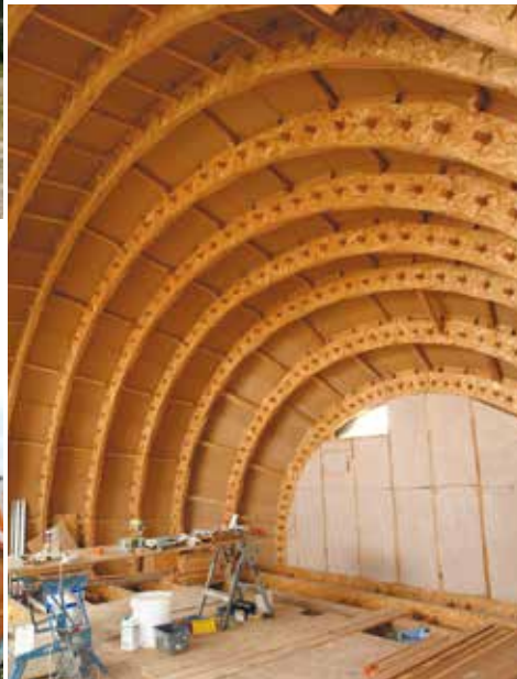
Les écoquilles, en forme de coque de bateau renversée. Celle d'Alain, intègre un mur en bois cordé derrière une véranda : des rondins de bois bien secs noyés dans un mortier de chaux. Le mur apporte de l'inertie appréciable à cette construction légère. Cette maison est aujourd'hui en vente.
