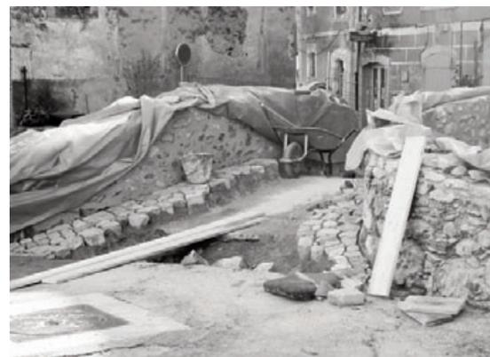
Le parapet du pont est presque terminé, et déjà, la calade se dessine sur les bords de la chaussée.
