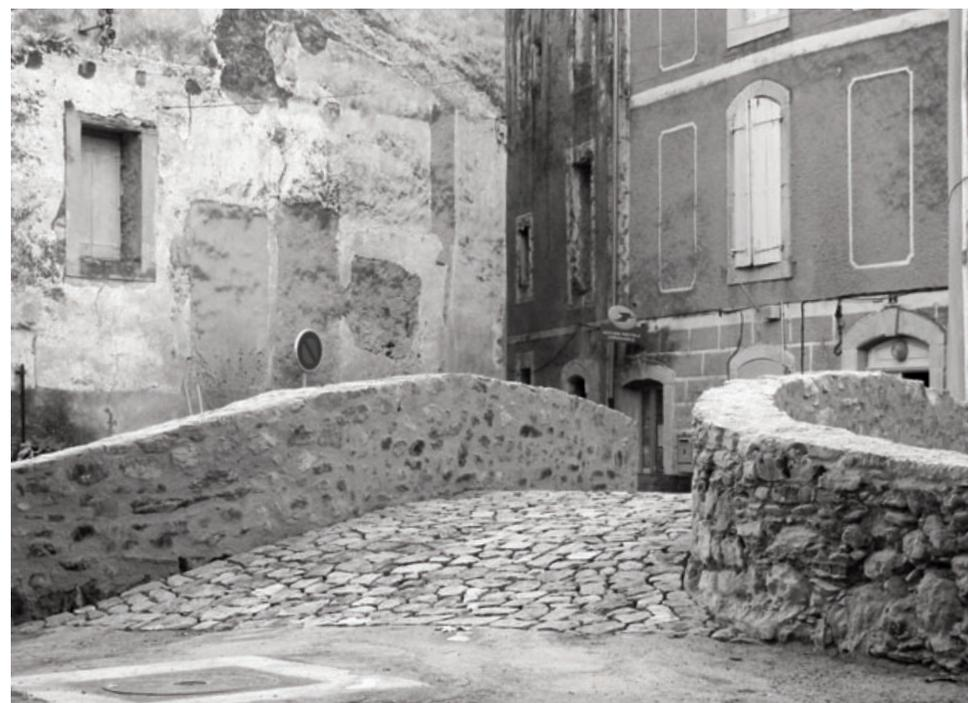
Mi décembre, la calade du pont de Chazal est en place, il ne reste plus qu'à attendre des températures légèrement plus clémentes pour poser les joints entre les pierres.
