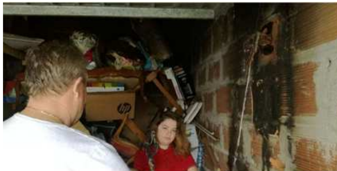
▲ Emma a alerté son père, après avoir découvert que le feu s'était déclaré dans le garage, au niveau du compteur d'électricité, dont il ne reste rien. ©PHOTO D. A.
