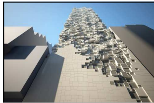
Hôtel à Hong Kong, par Heatherwick Studio
