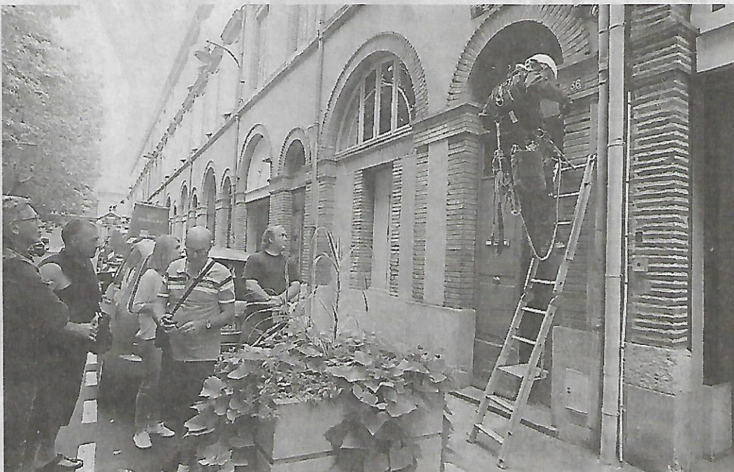
Le service d'intervention d'Enedis remet le courant : Cloé Chauvaud et les adhérents de l'association CMGA assistent au branchement, soulagés et opiniâtres.
