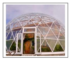
Construit à partir de sable, d'eau, d'argile et de paille, ce dôme géodésique de 7,6 m est réparti sur trois étages.
