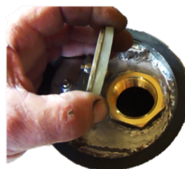
Tuyau d'arrivée d'eau
