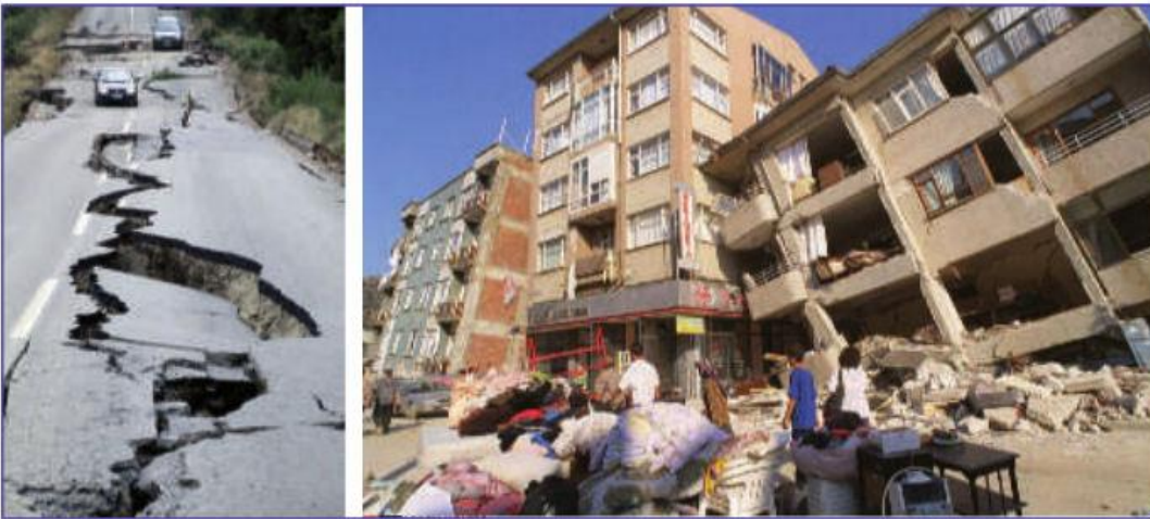
DOC. 1 Dégâts causés par des séismes : au Chili (à gauche), en Turquie (à droite)
