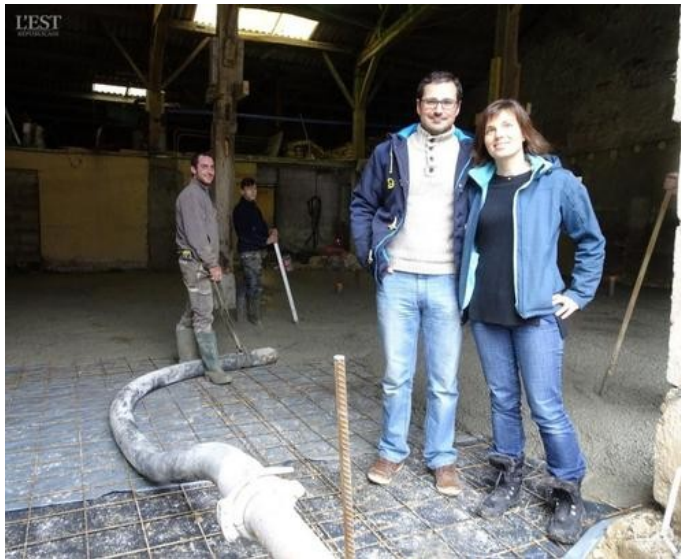
Hélène et Vladimir supervisent la coulée de la dalle de leur future fromagerie.
