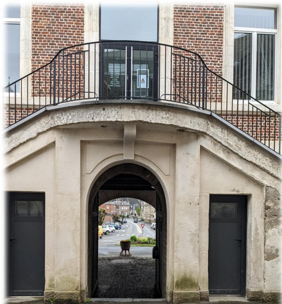
SIGNY L'ABBAYE Façade arrière de la mairie
