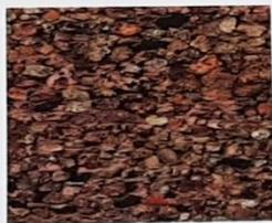
Le **rocaillage** teinté par de la brique pilée, dit « plein » dans lequel des éclats de meulière recouvrent totalement la maçonnerie.
