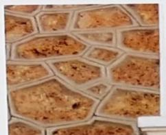
Dans le **jointoiment rubané**, les moellons sont entourés d'un joint saillant souligné d'un trait qui met en valeur leur irrégularité.
