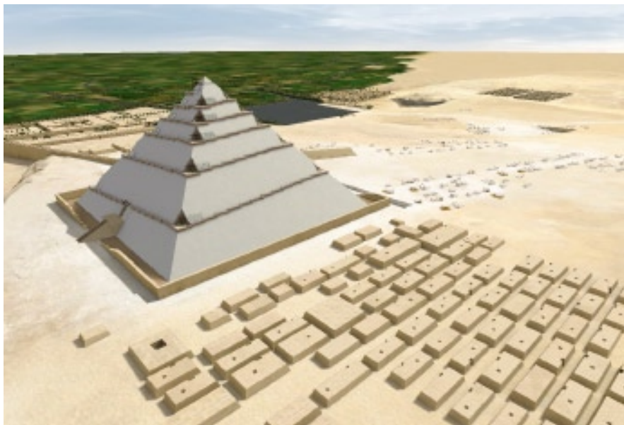
20ème année du règne. Le sommet est atteint, les travaux de parachèvement vont commencer depuis le sommet et en redescendant : rebouchage des encoches, démontage de la coursière extérieure, surfacage des derniers blocs de façade encore bruts.
