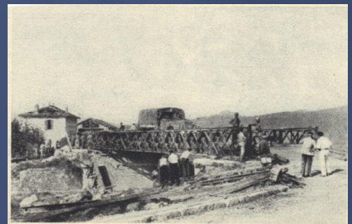
Le pont provisoire lancé par le Génie sur le Gapeau Source : La Première Division Française Libre dans le Var
