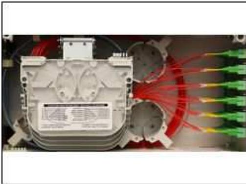
La fibre optique principale en provenance du central et du point de distribution arrive directement dans une chambre de raccordement. Un boîtier d'épissure hermétique, fixé dans la chambre, accueille un coupleur optique (splitter) où la fibre est "éclatée" pour être divisée en 8 sous-fibres au maximum.
