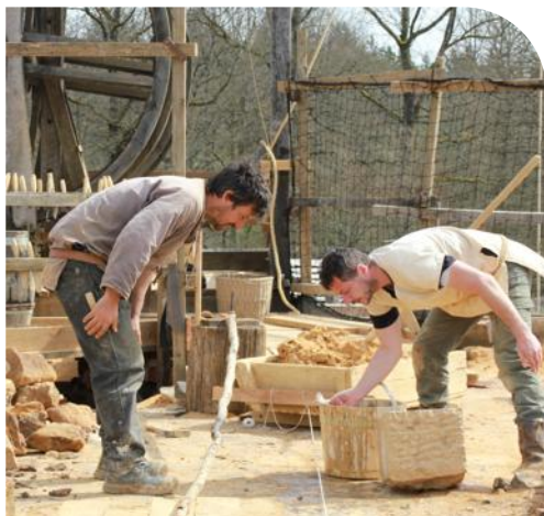
Les maçons travaillent sur la porte du château et ses 2 tours.
