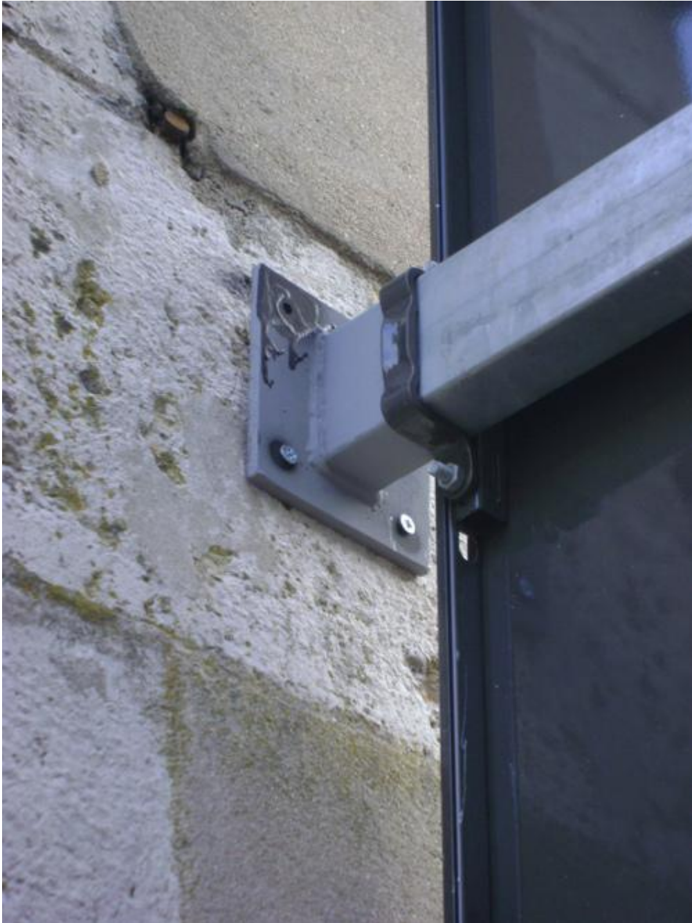
Panneau (autre détail). Plus de vis du tout ! - Cliquer sur la photo pour l'agrandir
