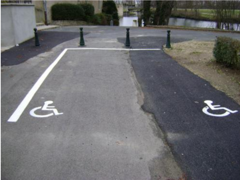
Place de stationnement PMR au pied de l'escalier de la rue du Bout du Monde - Cliquer sur la photo pour l'agrandir
