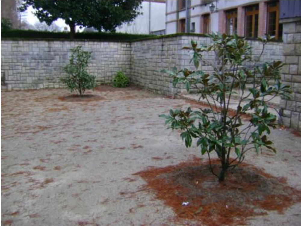
Les mêmes magnolias replantés en pleine terre (au pied de l'escalier du Passage des Douves/Promenade des Douves) - Cliquer sur la photo pour l'agrandir
