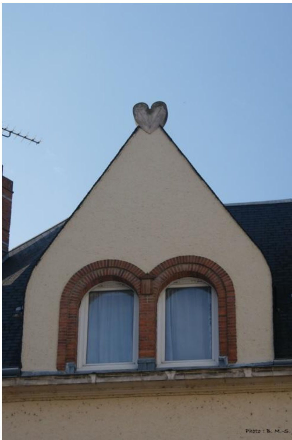
Pignon de maison (angle de la rue du Grand Sully et de la rue des Ecoles) - Cliquer sur la photo pour l'agrandir
