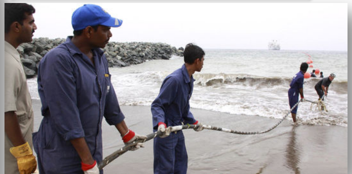
Déploiement du câble sous marin en fibre optique à Fujairah (Emirats arabes unis).
