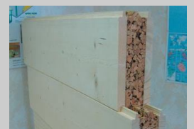
Isolation des murs en granulés de liège
