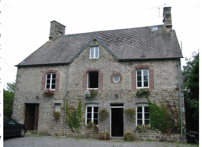
Maison d'habitation au cœur du site du château de La Roche-Tesson à La Colombe
