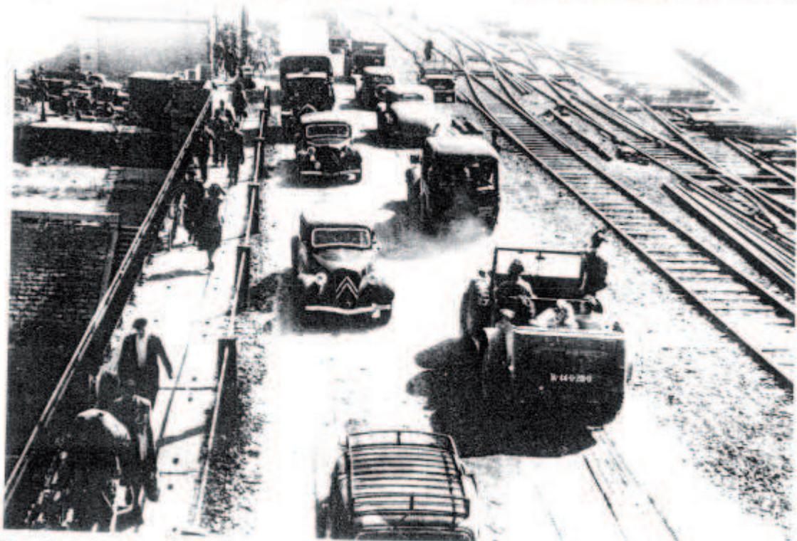
Tous les ponts, qu'ils soient des voies ferroviaires ou routières étant détruits, ce seul viaduc servira en même temps à la circulation des trains et des voitures. Les rails de la moitié de l'ouvrage sont sablés permettant ainsi le passage des véhicules automobiles.
