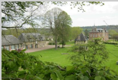
Vue sur l'enceinte du Prieuré
