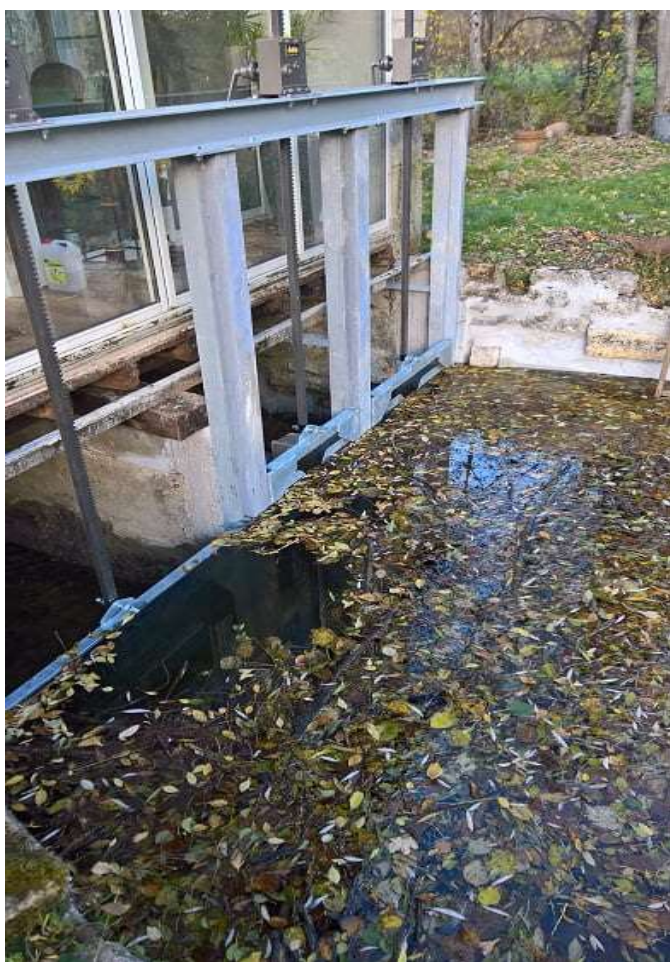
Photo de gauche : Mise en eau réalisée. Le niveau d'eau de référence (0.93m) pour la régulation automatique est quasi atteint. Les vannes sont encore fermées. Photo de droite : Le niveau est dépassé, les deux vannes automatiques sont ouvertes et régulent en autonomie. La chasse d'eau s'effectue en pied de vanne.
