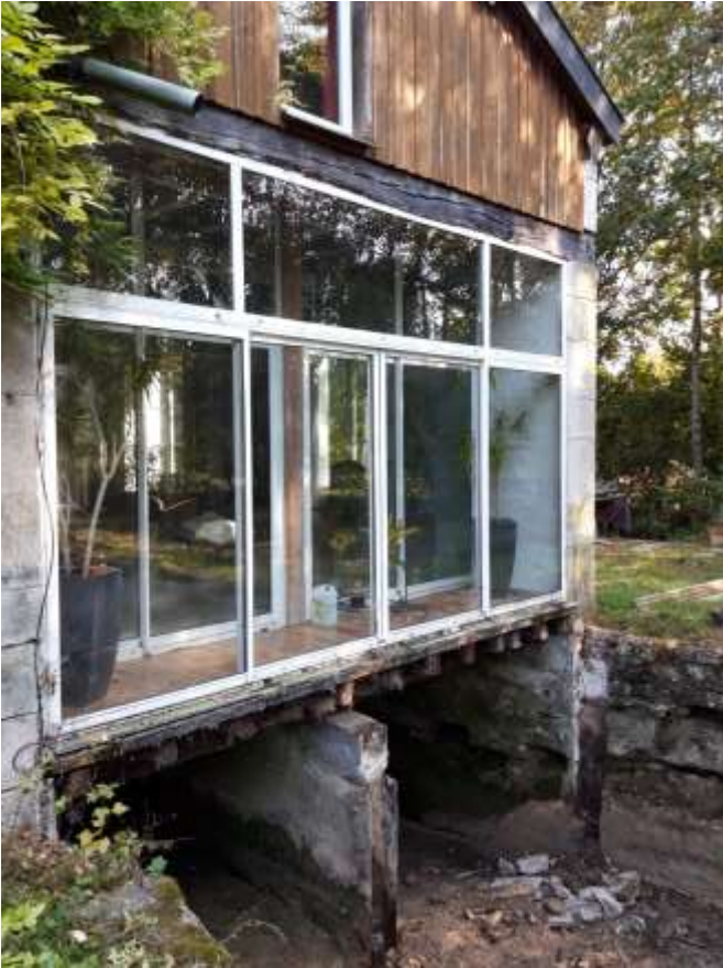
Photo prise au début des travaux- Mise à sec de la rivière-Ancienne structure bois retirée
