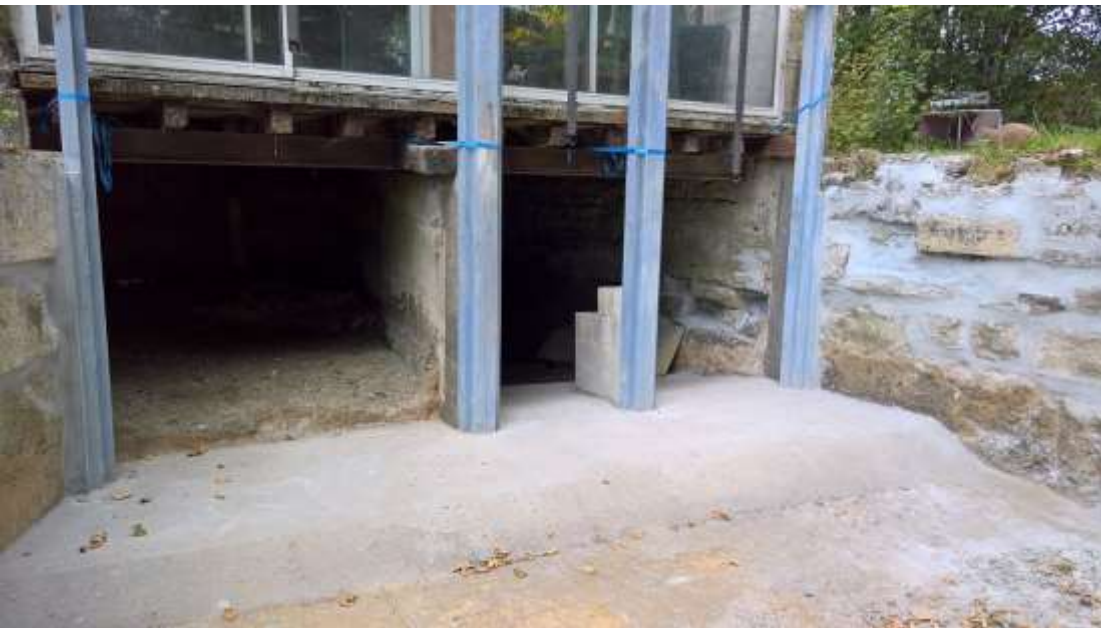
Photo prise après la première phase des travaux réalisés : Réalisation et pose d'une structure en acier, travaux de génie civil réalisé (rénovation fondation, murs, seuil)-Temps de séchage à respecter avant la fin des travaux
