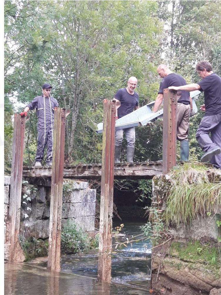
Les nouvelles vannes s'insèrent dans le bâti existant au mm près (d'où l'importance de la prise de cotes )
