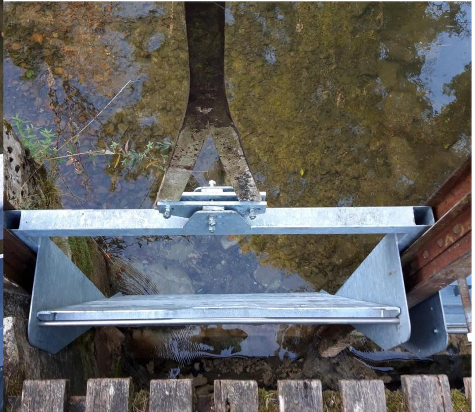
**Installation terminée = Mise en eau à réaliser pour une autorégulation des vannes à une hauteur déterminée**
