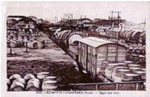
Transport de fûts en gare de Lézignan-Corbières (11)
