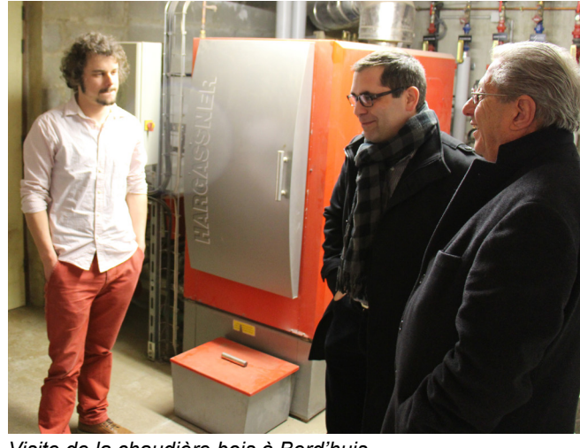
Visite de la chaudière bois à Berd'huis.
