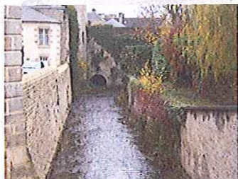
Mur restauré sur la base des murailles
