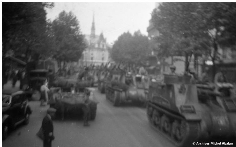
Entrée à Alençon le 12 août 1944
