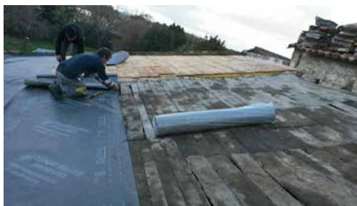
▲ Réfection de la toiture du local de l'ancien atelier près de la Cure.
