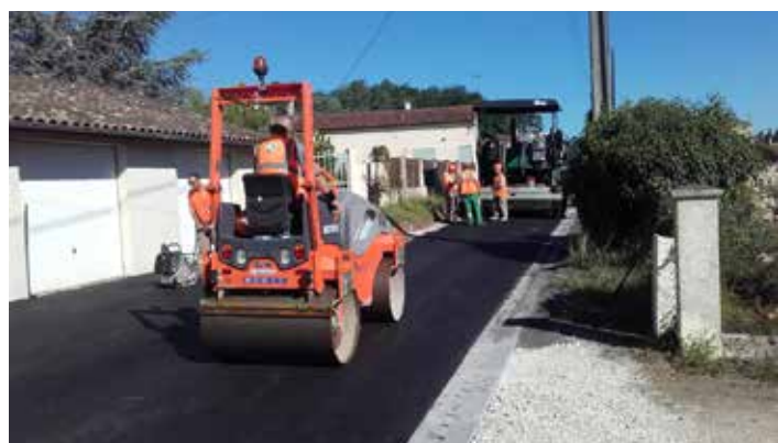
▲ D'importants travaux de voirie ont été réalisés en 2017.
