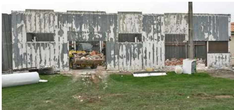
▲ La « verrue » qui servait de vestiaires avant la démolition.
