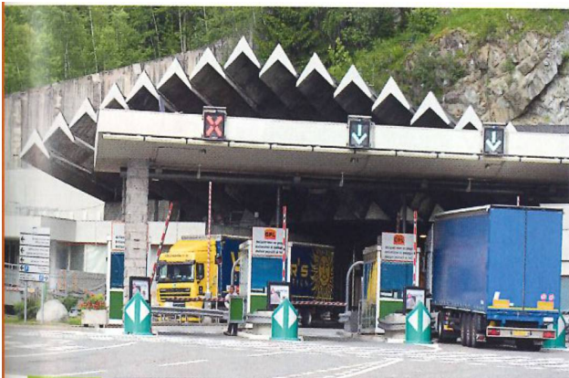
Doc 4 Le tunnel du Mont Blanc entre la France et l'Italie
