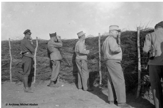
Poste de guet à Fouras – 17 avril 1945
