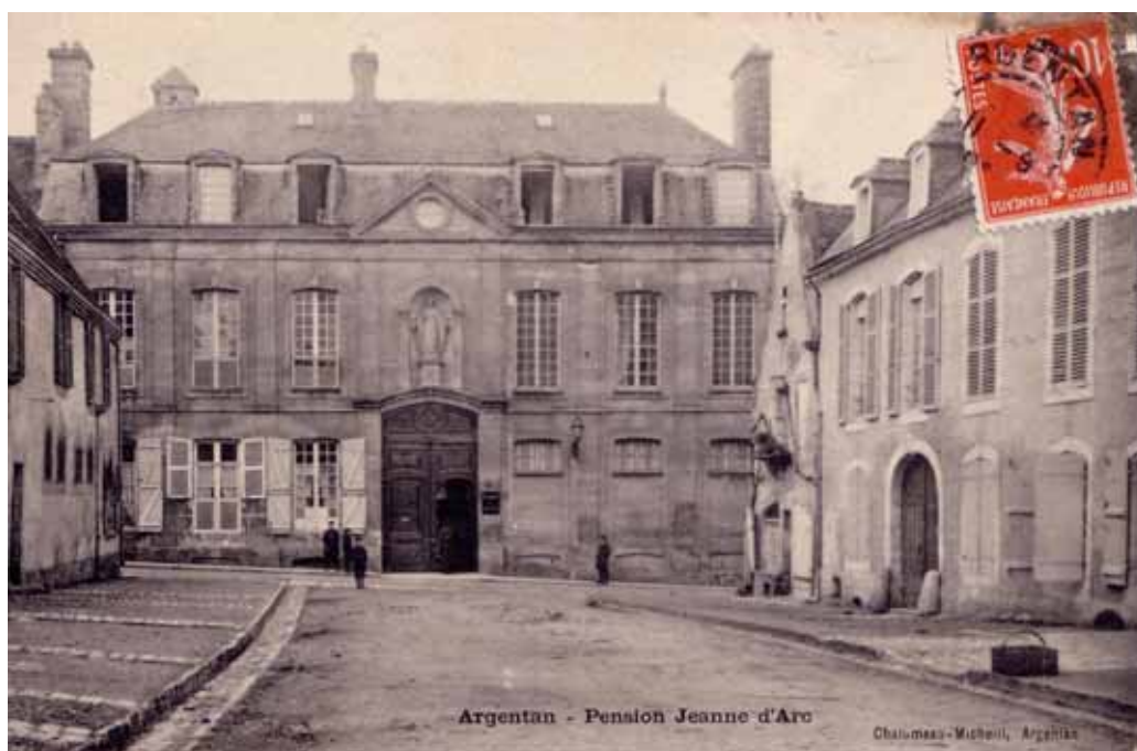
Entrée de l'Institution Jeanne d'Arc rue de la Poterie (photo prise de la rue des Vieilles Halles) Le bâtiment était situé à l'entrée de l'actuelle rue Georges Meheudin. Il a été détruit à la Libération.
