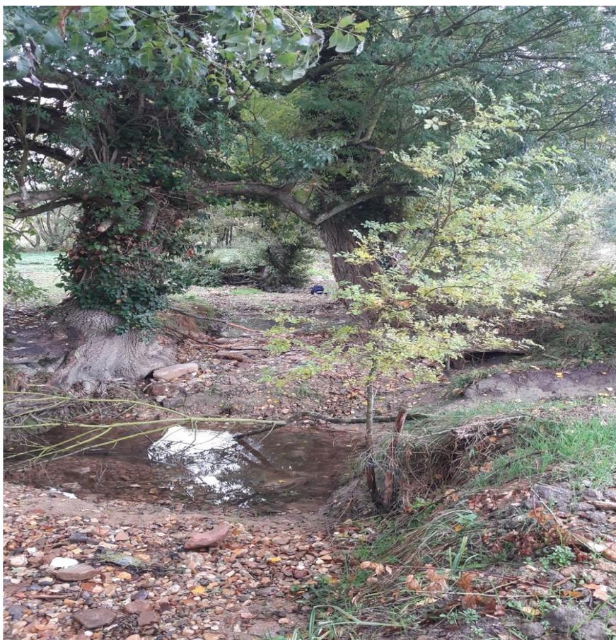
Aménagement de passe à poissons naturelle (réalisée à l'aide de blocs et pierres disposés à l'aide d'une pelleuse) d'une longueur de 100m caractérisée par une succession de fosses et radiers.
