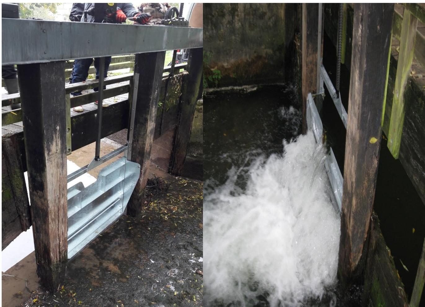
**Caractéristiques Vanne Panavan (Hauteur 1.620 \* Largeur 1.360/Poids : 120 kg/Hauteur d'eau à réguler : 1m)**
