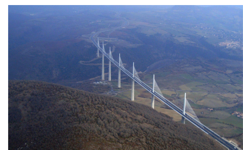
Viaduc de Millau
