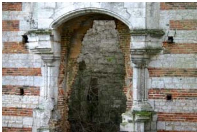
Figure 59 : Cheminée du niveau 2 de la Grande chambre
