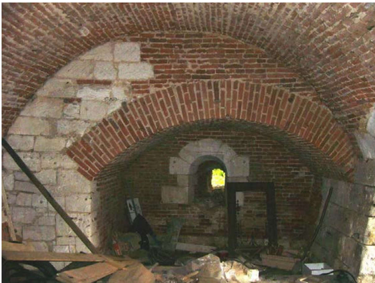
Figure 23 : Vue intérieure du RDC de la Tour du lion. En face, canonnière ; sur la droite, talus du mur primitif
