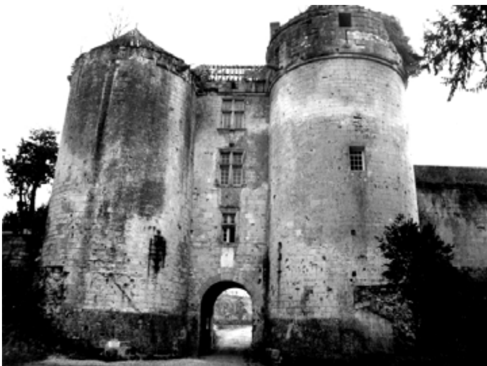
Figure 9 : Vue actuelle de la porte d'entrée
