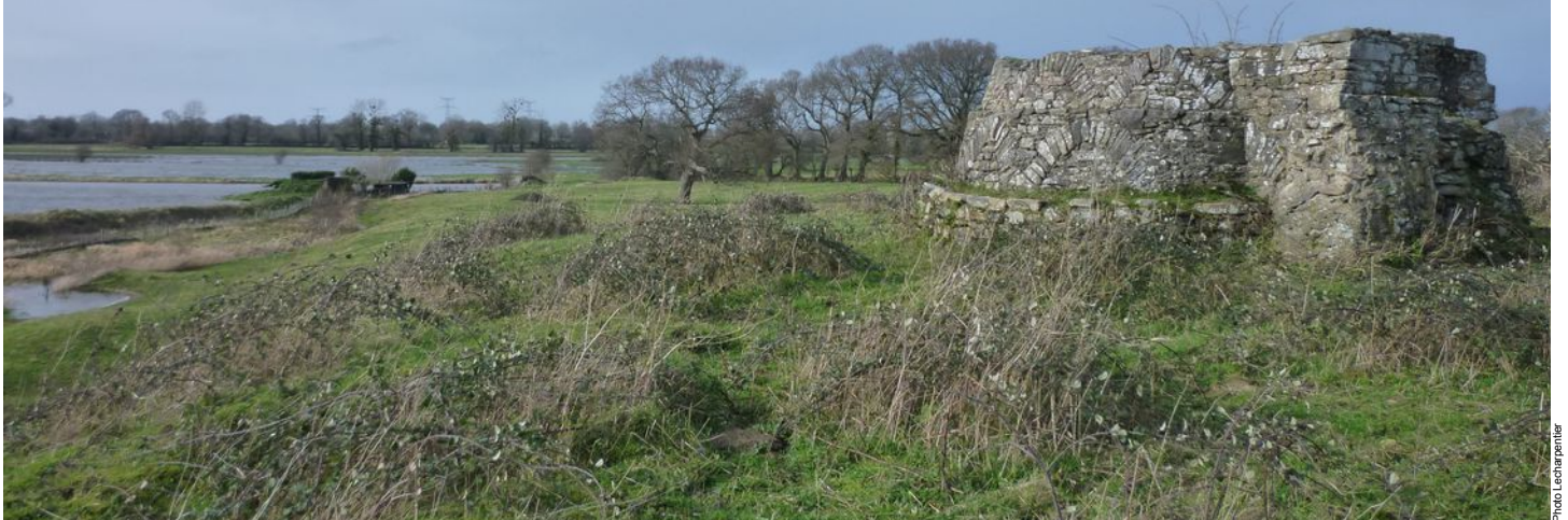
Fondation d'une des tours avec ses voûtes sur la motte où il faut s'imaginer le paysage avec beaucoup moins d'arbres. Des feuilles ont diminué la hauteur de la motte.
