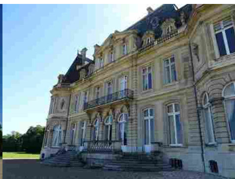
La façade est du château
